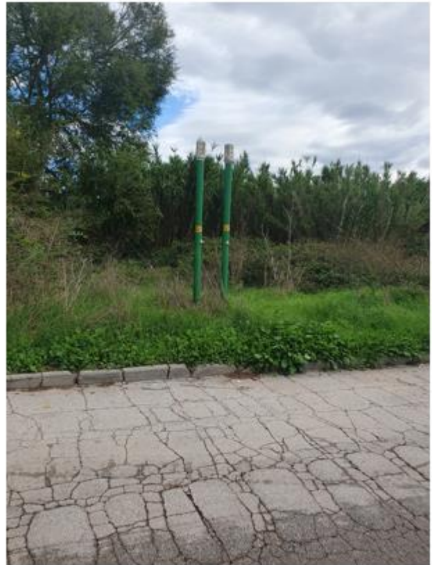
Foto 6: Particolare dei picchetti di segnalazione del passaggio del metanodotto
