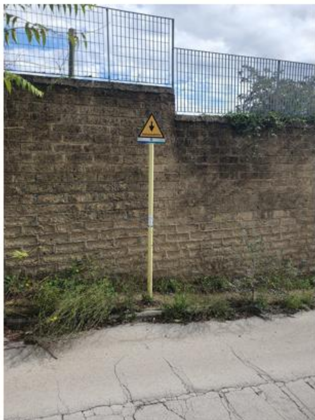
Foto 5: Particolare dei picchetti di segnalazione del passaggio del metanodotto
