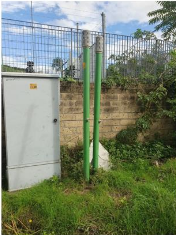
Foto 6: Particolare dei picchetti di segnalazione del passaggio del metanodotto
