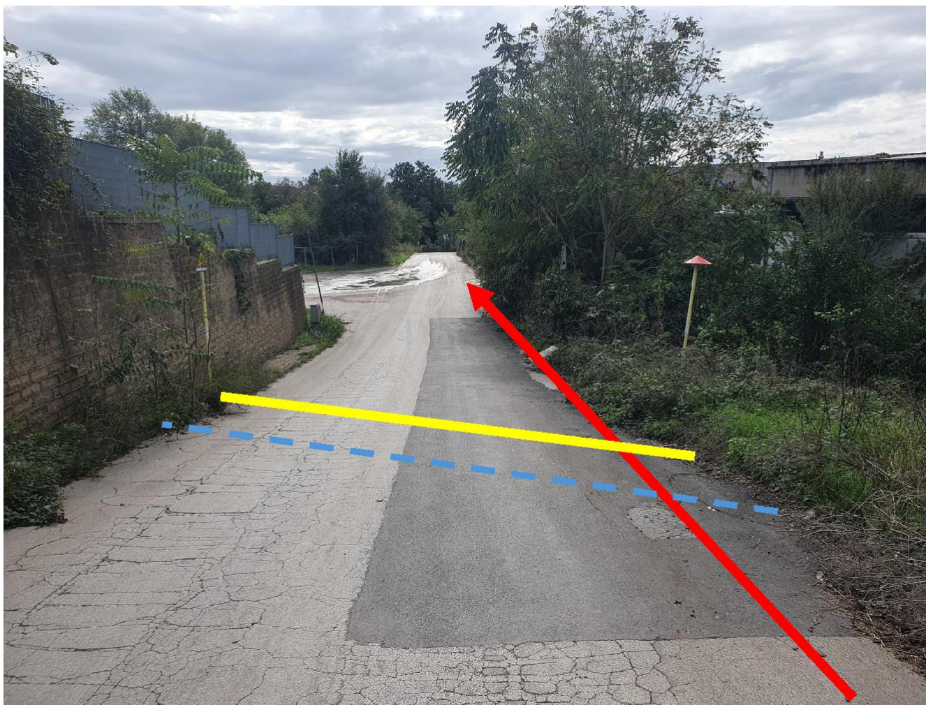
Foto 4: interferenza con metanodotto e tubazione di scarico acqua
