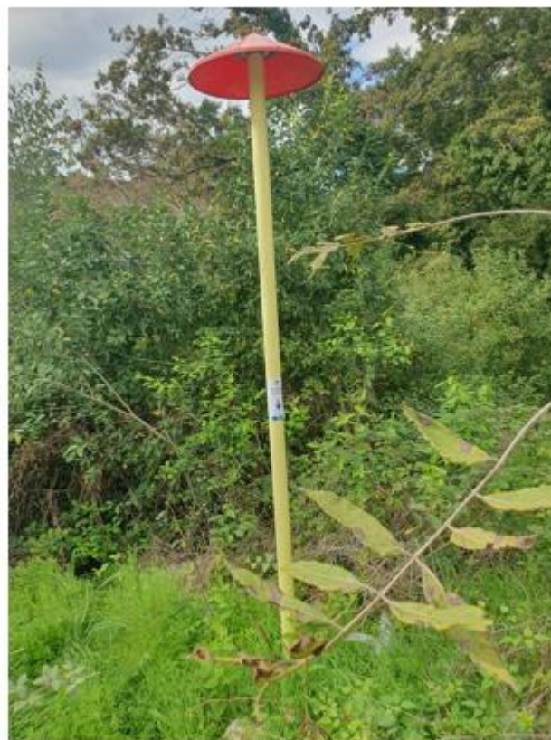
Foto 5: Particolare dei picchetti di segnalazione del passaggio del metanodotto
